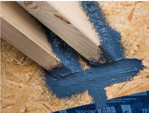
9. Fertig angeschlossene Zangendurchdringung
